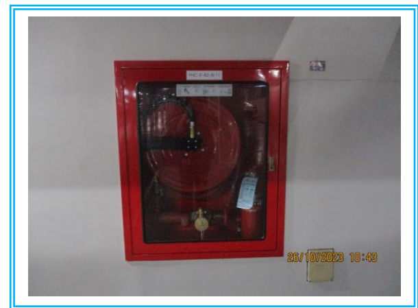
รูปที่ 3-46 การติดตั้งถังดับเพลิงในตู้สายฉีดน้ำดับเพลิง บริเวณลานจอดรถ และพื้นที่ส่วนกลาง
