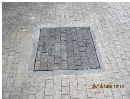
รูปที่ 3-33 บ่อทวงน้ำสำหรับพื้นที่รับน้ำ B
