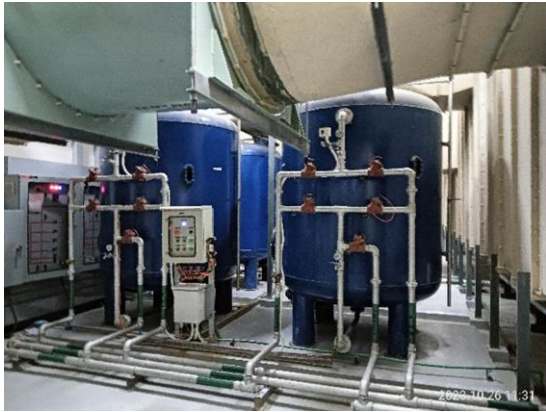
รูปที่ 3-29 ระบบกรองน้ำเสียจากระบบบำบัด
