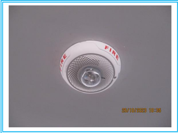
รูปที่ 3-51 อุปกรณ์ส่งสัญญาณแจ้งเหตุ (Alarm Bell)
