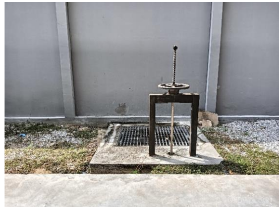
รูปที่ 3-32 บ่อทวงน้ำสำหรับพื้นที่รับน้ำ A
