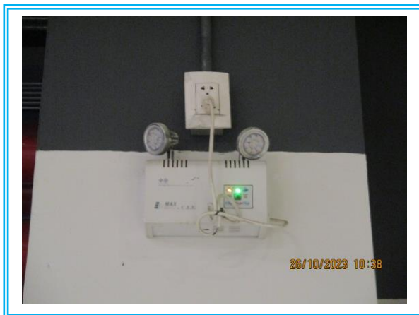
รูปที่ 3-55 การติดตั้งไฟฉุกเฉิน (Emergency Light) ตามจุดต่างๆ ภายในอาคาร
