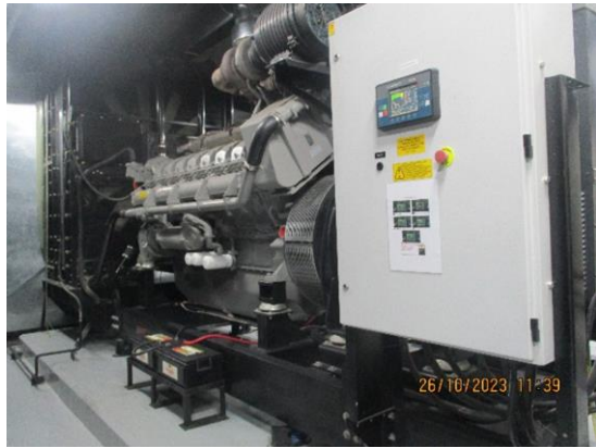
รูปที่ 3-10 ห้อง generator มีการבודกั้นเสียงไม่ให้มีเสียงดังรบกวนออกไปภายนอก
